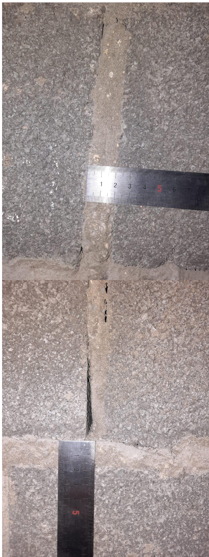
Фотография 22-23. Замер толщины кладочного шва
