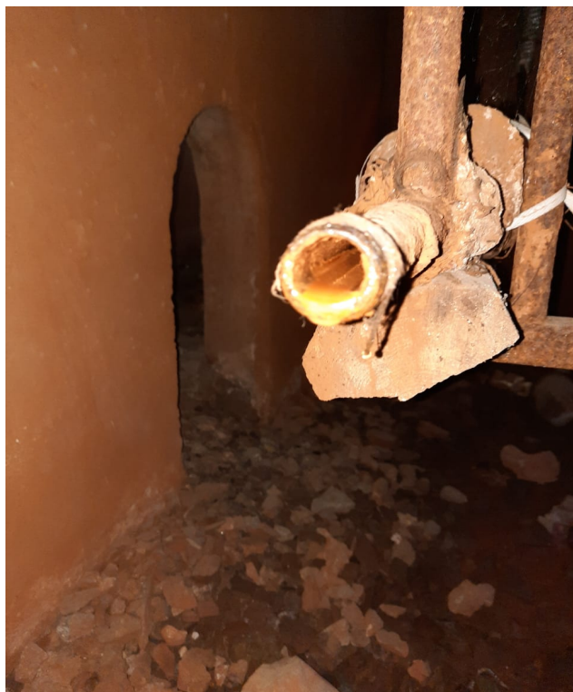
Фотографии 1-4. Повсеместная коррозия, неисправности задвижек.
