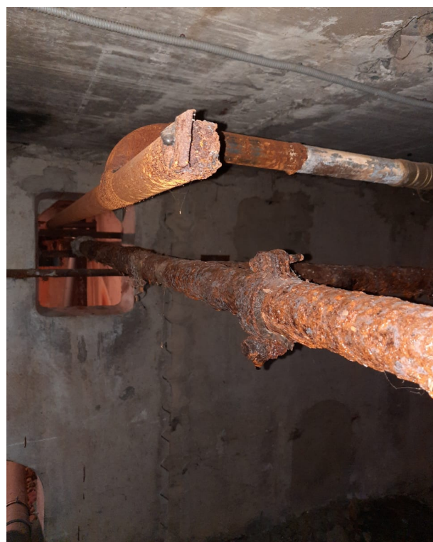
Фотографии 1-4. Повсеместная коррозия, неисправности задвижек.
