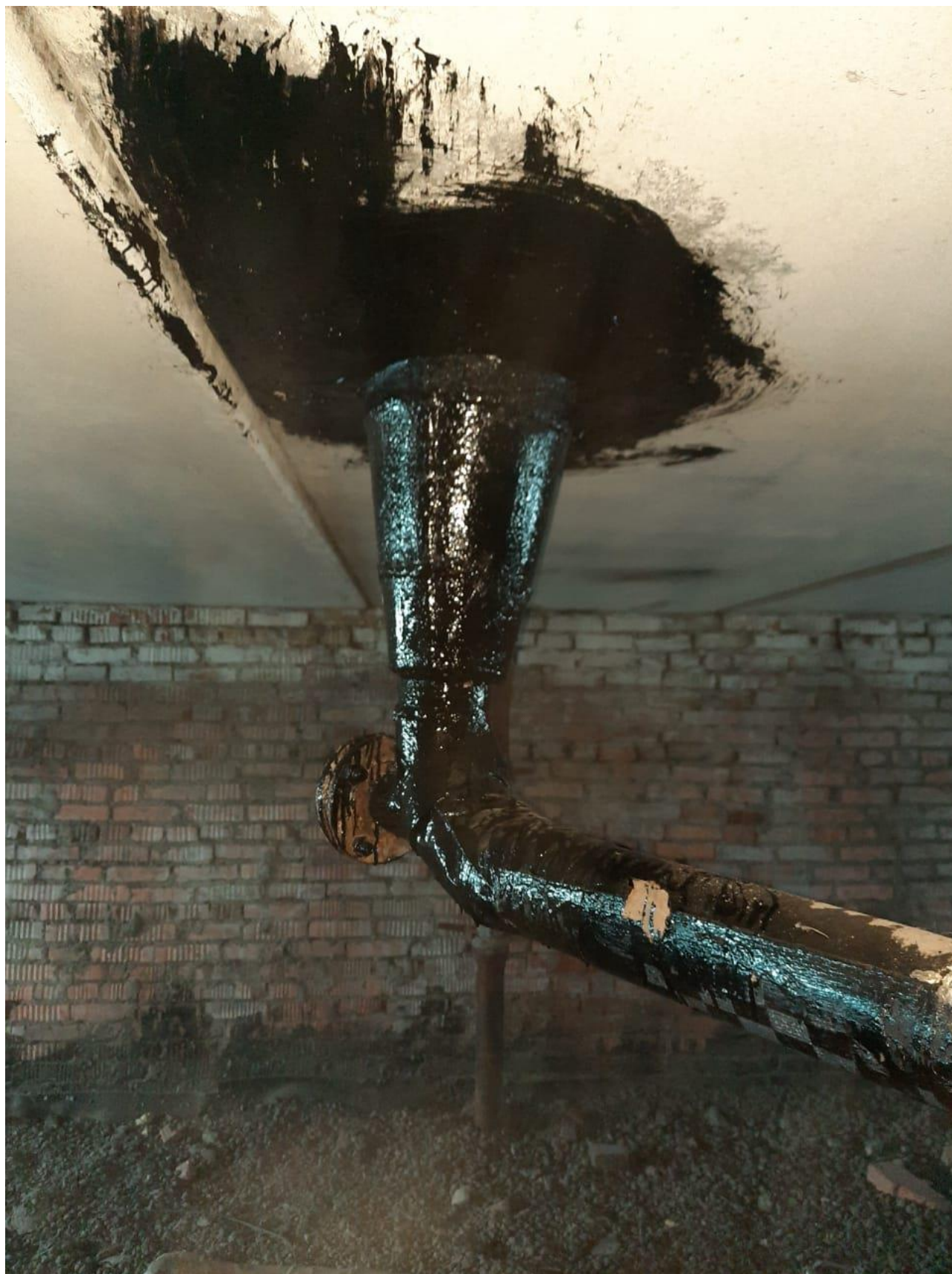
Фотография 8. Дренажная система имеет угол 90 гр. и замятия в углах.
