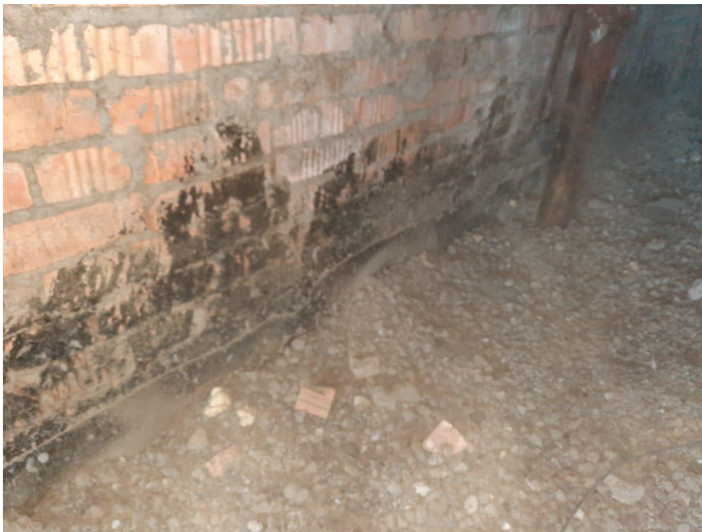
Фотографии 2. Гидроизоляция отслаивается, под керамзитом отсутствует частично или полностью.
