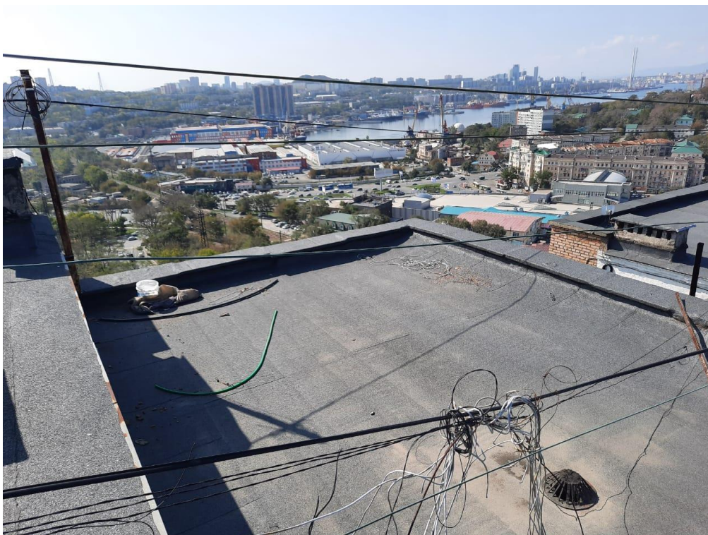
Фотографии 2. Гидроизоляция отслаивается, под керамзитом отсутствует частично или полностью.
