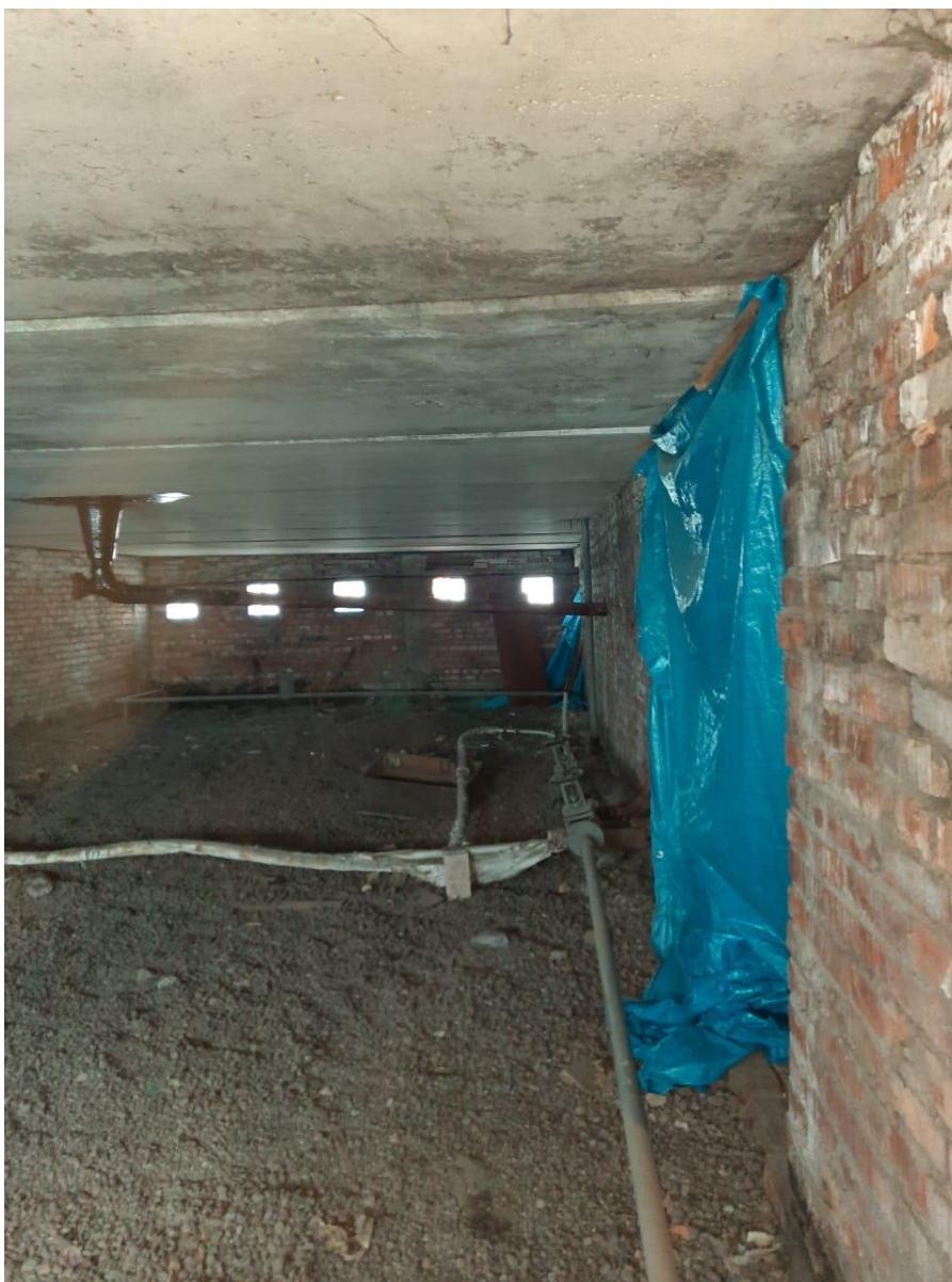
Фотографии 1. Технический этаж
