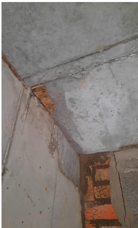
Фотографии 7,8,9,10. Остатки опалубки и посторонние предметы в монолите.
