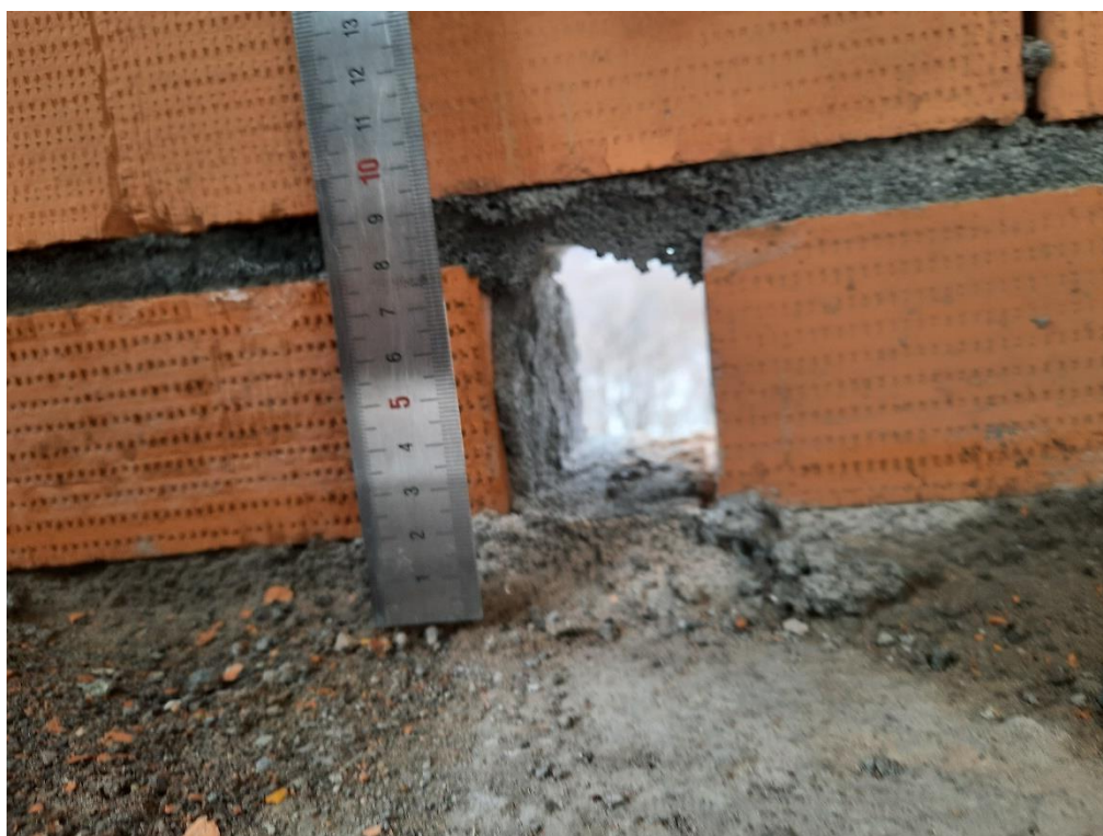
Фотографии 34-35. Уровень сливных отверстий на балконе и лоджии по отношению к перекрытию.
