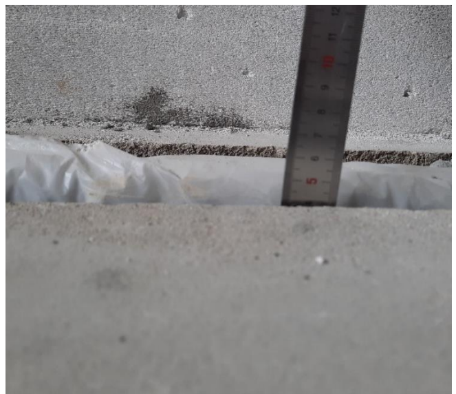
Фотографии 26-31. Дефекты устройства стяжки пола.
