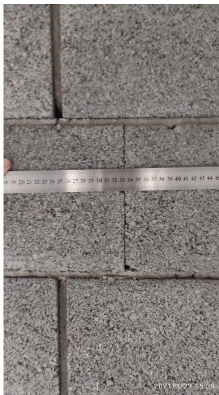
Фотографии 20-22. Отклонения от линейных размеров кладочных швов
