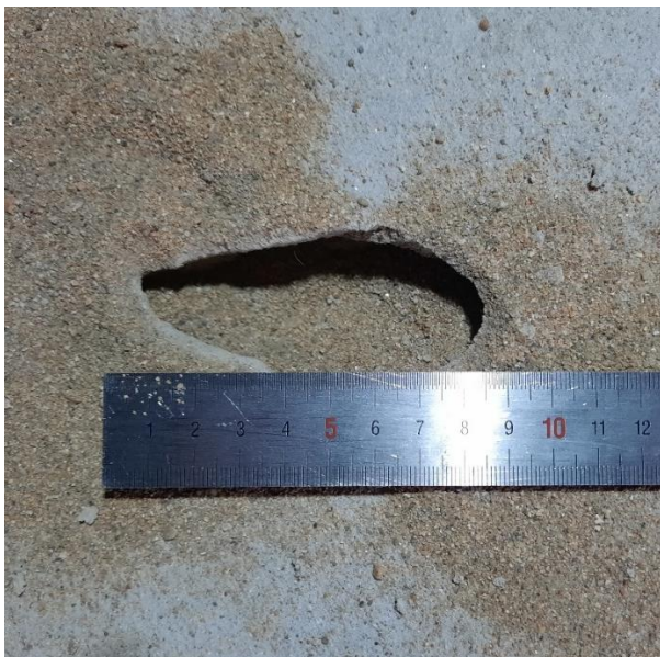
Фотографии 26-31. Дефекты устройства стяжки пола.
