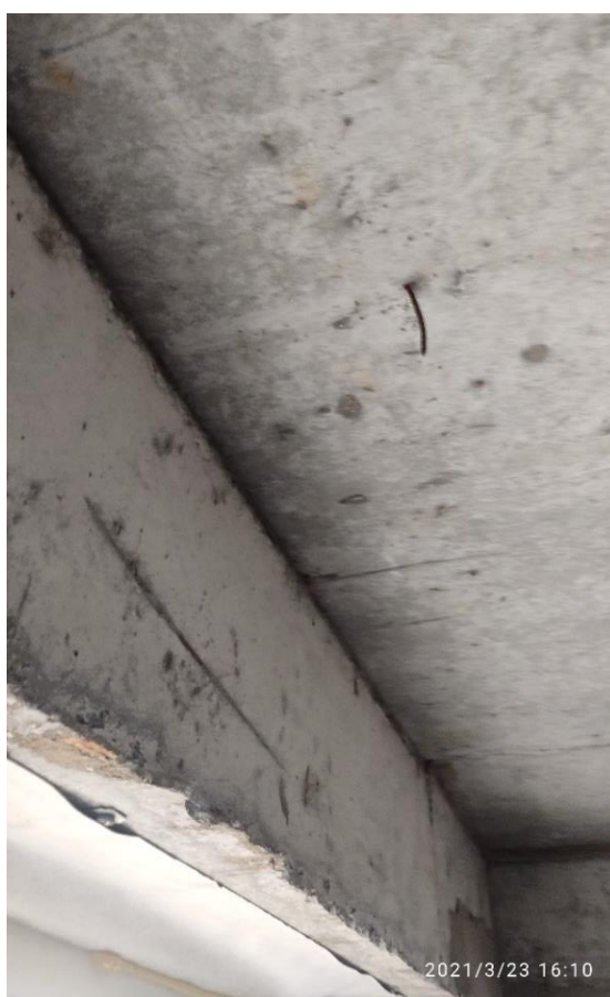
Фотографии 7,8,9,10. Остатки опалубки и посторонние предметы в монолите.
