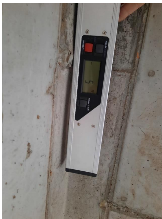
Фотография 4,5,6. Наплавы бетона, искривление по вертикали монолитных стен
